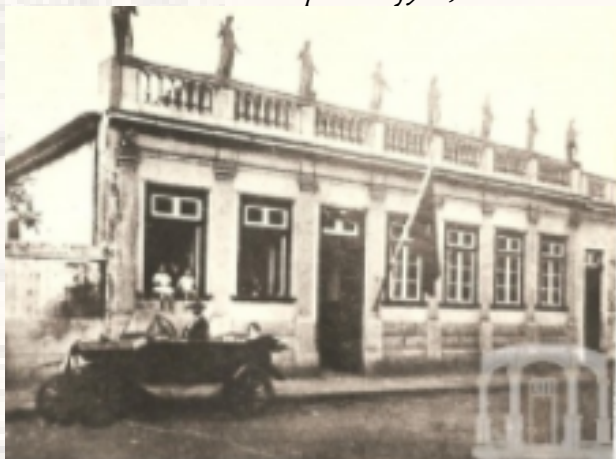
Figura 30: Residencial União dos Moços Católicos Tombamento: Decreto Municipal n.º 3918, de 20 de maio de 1985.
